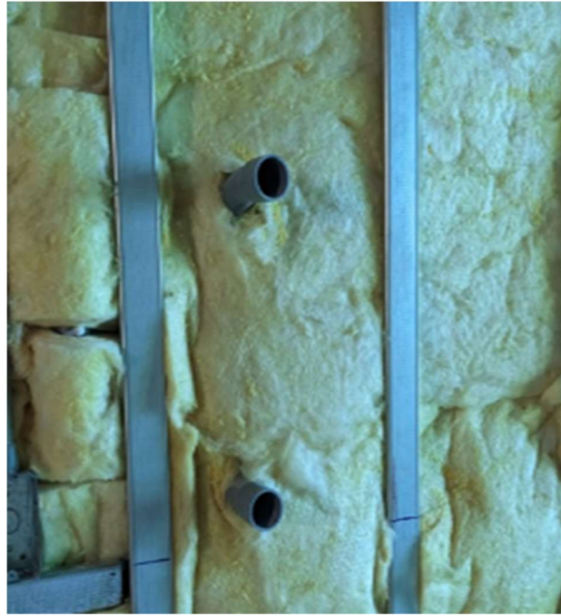
電子床頭卡與氣體牆的管線
